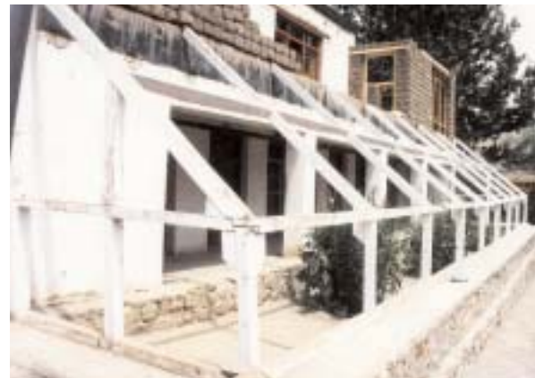
Nachträgliche Kostruktion zur Erwärmung der Schule in Saspol
