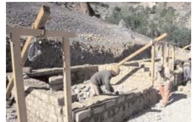
Einbau der Tür- und Fensterstöcke in das aufgehende Mauerwerk
