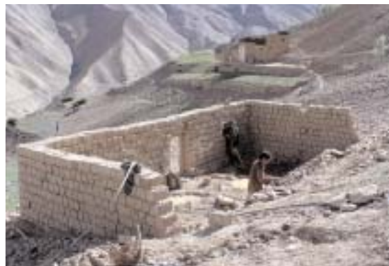
Hochziehen der Mauern
