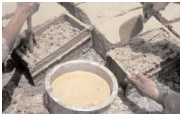
Die Herstellung der Lehmziegel erfolgt vor Ort, der Lehm wird nass gemacht, gemischt und in Formen gestopft.
