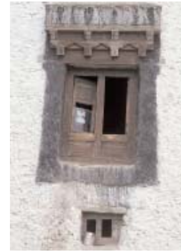
Erdgeschoßluke und Obergeschossfenster
