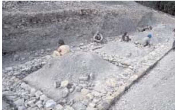
Einebnen des Grundstückes und Fundamentierung mit Steinen, ca. 90cm tief
