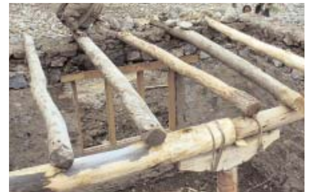
Verlegung der Deckenbalken und Steher
