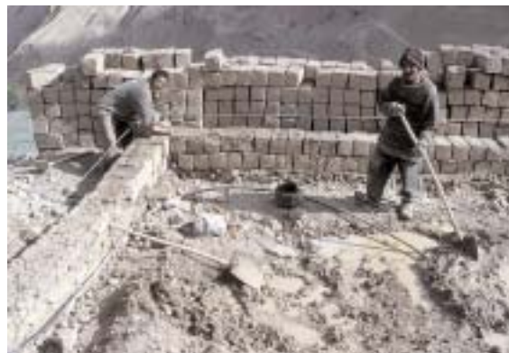
Eine Schnurbank ist auch in Ladakh wichtig für das Ausrichten
