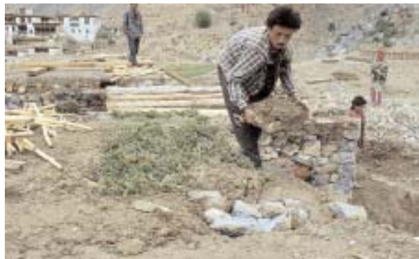
Abdecken des Daches: Als letzte Deckschicht kommt ein spezieller Lehm, der oft von weit hergeholt werden muss. Erst diese Deckschicht macht das Dach dann wasserdicht. Meist werden 3-5 Lehmschichten aufgebracht und nach einiger Zeit wieder erneuert
