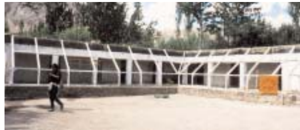
Attached greenhouse, nachträglich vor ein Schulgebäude in Saspol
