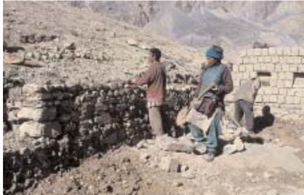
Aufbau der Grundmauern im Hang mit Steinen, darüber mit Lehmziegeln
